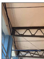
Čelična konstrukcija sa oštećenjem oslonca uslijed slijevanja
